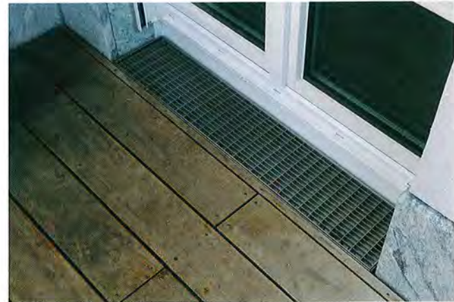
Gitterrost vor Terrasseneingangstür
