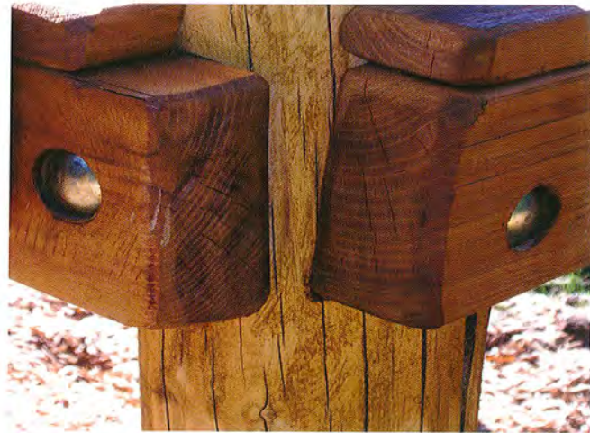
Handwerklich konstruktiver Holzschutz: Die Lage der Hölzer – Kernseite nach oben, so dass die radialen Schwind- / Trockenrisse schräg nach unten verlaufen und keine Wassertaschen bilden können. Foto: © J. Plößl
