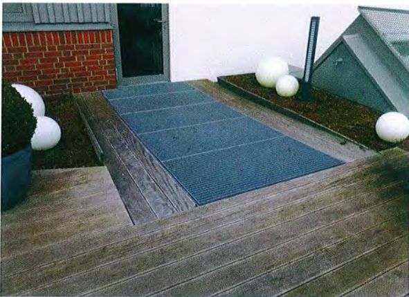
Gitterrost als Sauberlaufzone vor Hotelhintereingang – unter einer Sauberlaufmatte würde das Holz faulen. Foto: © T. Wilper
