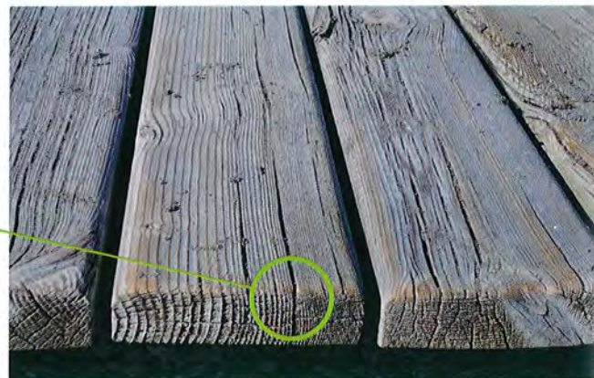
Patina der Kiefern KDI-Bretter nach 5 Jahren Wind-, Wasser- und Seeluft hat keinen Einfluss auf die Festigkeit.
